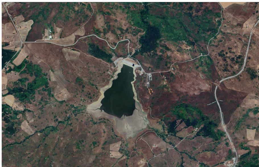
Fig. 2. Diga di Saetta
